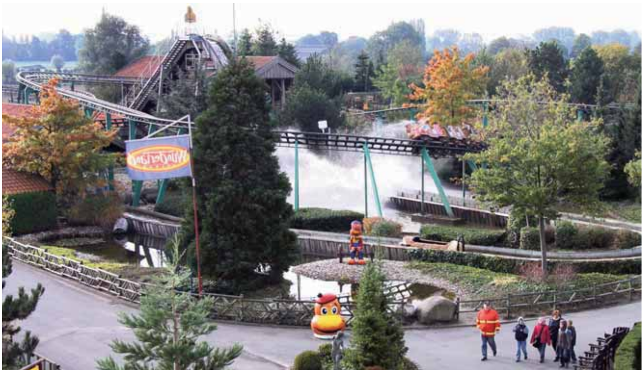
Isolierte Stromschielen U 30 in einem Fahrgeschäft
