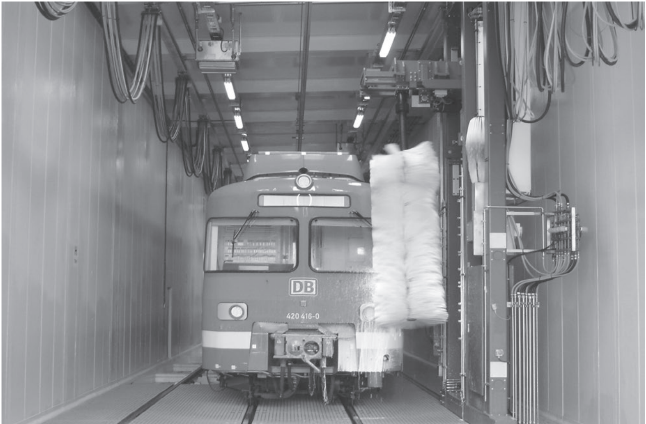
Leitungswagenanlage für eine Straßenbahnwaschanlage
